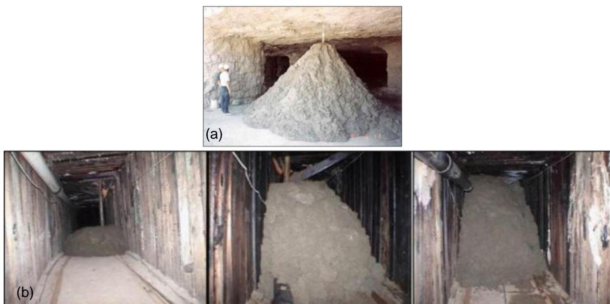
FIGURA 27: Exemplos de injeção LMG em minas abandonadas. (a) Enchimento de uma caverna - reprodução da Figura 22-2 de USACE, 2017 (b) Sequência de enchimento de um túnel – reprodução da Figura 22-3 de USACE, 2017, O material injetado é mais pesado que a água e, portanto, permite o preenchimento definitivo de cavidades submersas.
